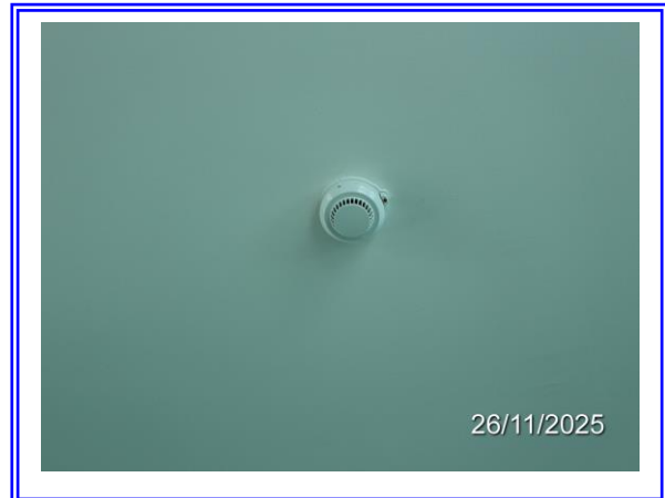
รูปที่ 3.1-35 อุปกรณ์ตรวจจับควัน
